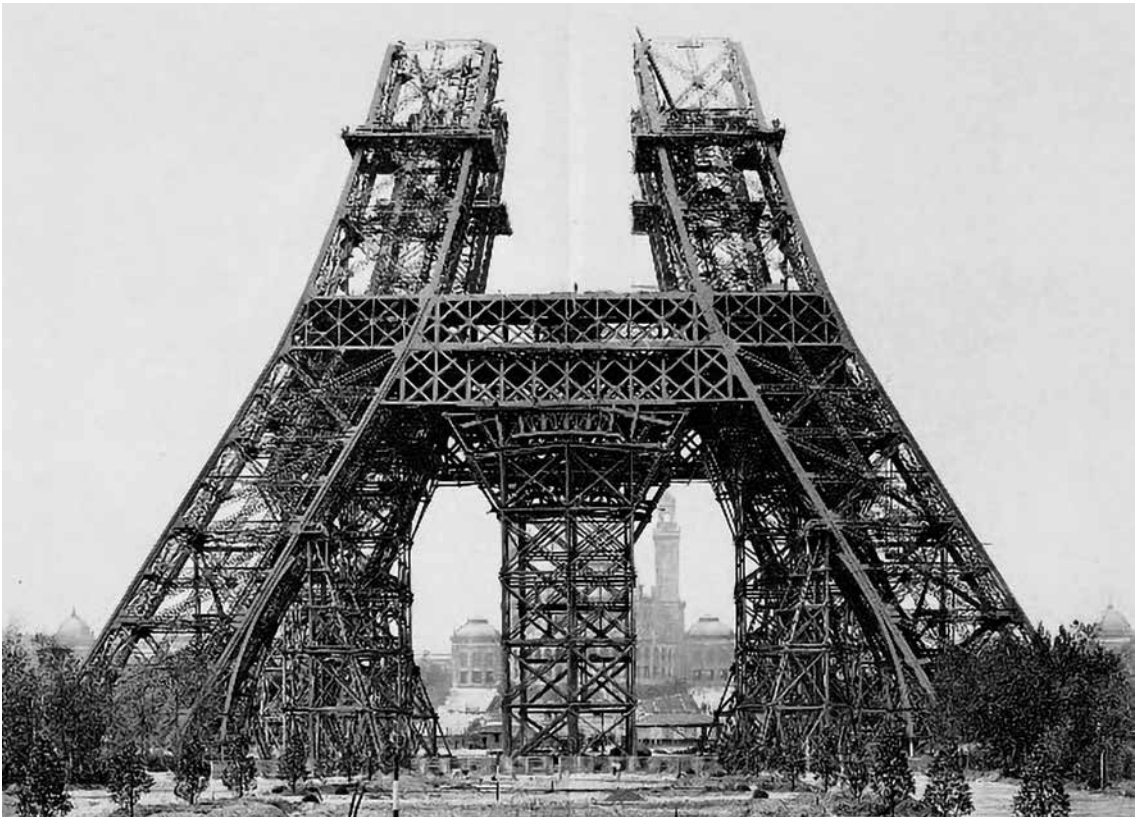
Constructie van de Eiffeltoren 1887-1889 [bron: commons.wikimedia.org]
